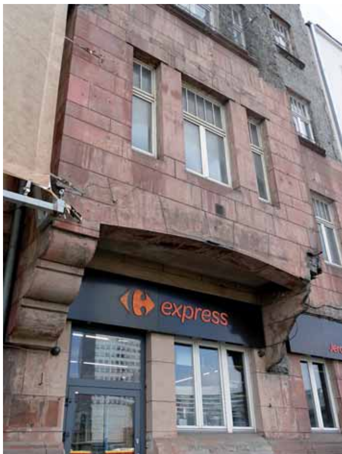
Ilustracja 1-15. Wsporniki u podstawy prawego wykusza w kamienicy przy Alejach Jerozolimskich 57, stan z 2017 roku. Fot. P. Kilanowski
