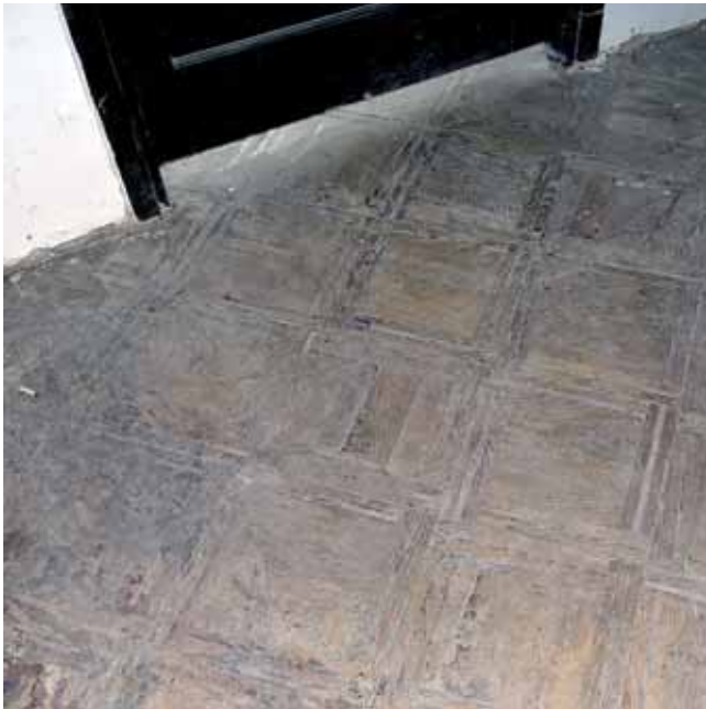
Ilustracja 1-19. Fragment drewnianej posadzki taflowej w jednym z pokoi w kamienicy przy Alejach Jerozolimskich 57, stan z 2017 roku. Fot. P. Kilanowski
