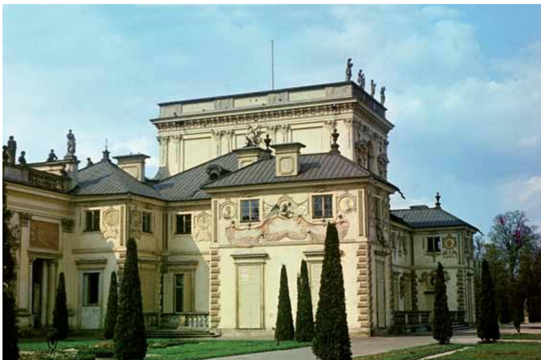
Ilustracja 2-16. Wilanów. I faza — ogród barokowy na Tarasie Górnym przy południowo-wschodniej elewacji pałacu. Fot. M. Brykowska, 1973
