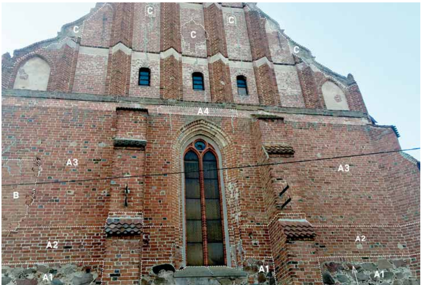
Ilustracja 4-5. Kościół w Barcianach — wschodnia ściana korpusu: A1–A4 — partie ściany powstałe w drugiej fazie budowy w pierwszym etapie i w jej kolejnych etapach, B — zamurowane wejście na empore, C — barokowe przemurowania szczytu. Opr. Monika Rygier
