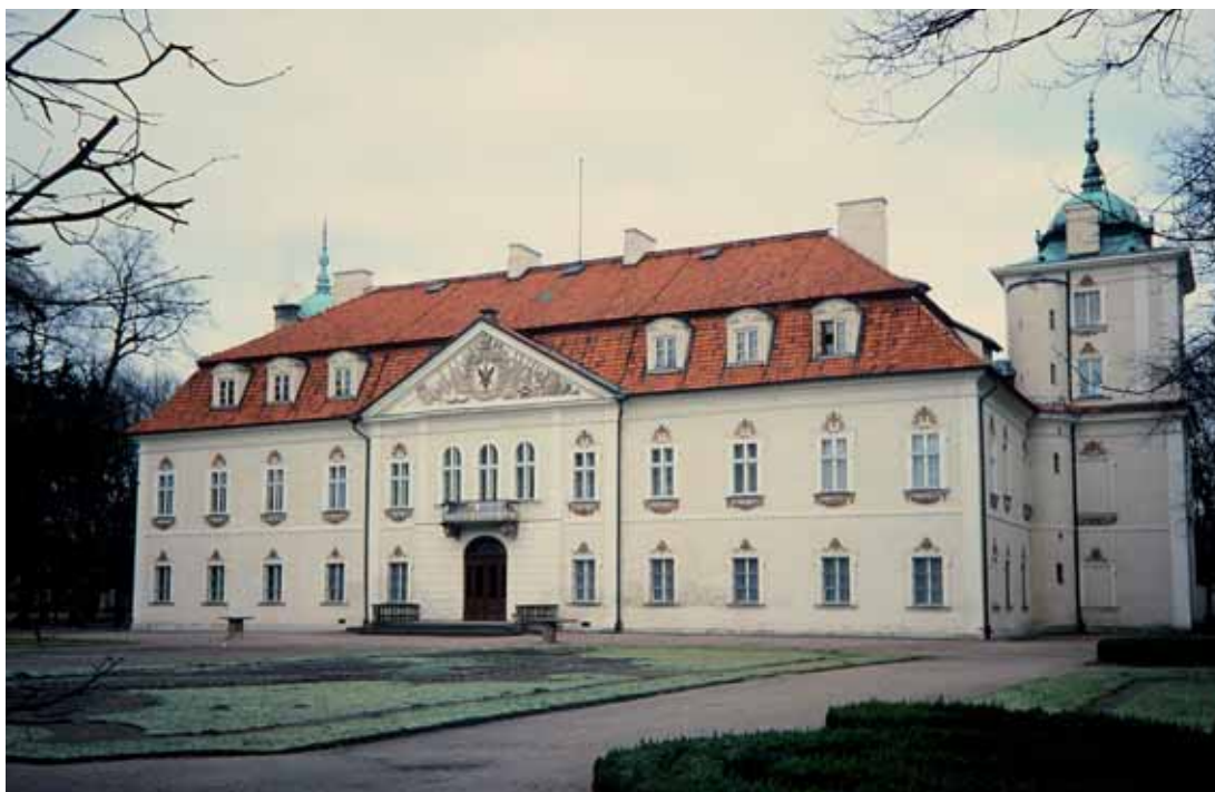
Ilustracja 2-24. Nieborów. Pałac, elewacja południowa od ogrodu, z terenem przeznaczonym na rabatę kwiatową. Fot. M. Brykowska, 1996
