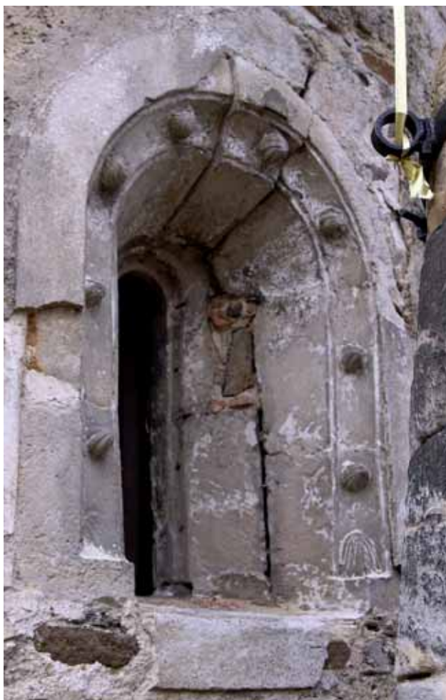
Ilustracja 5-3. Romańskie okno w absydzie dekorowane charakterystycznymi guzami w kształcie muszli. Fot. I. Krawiec, 2018
